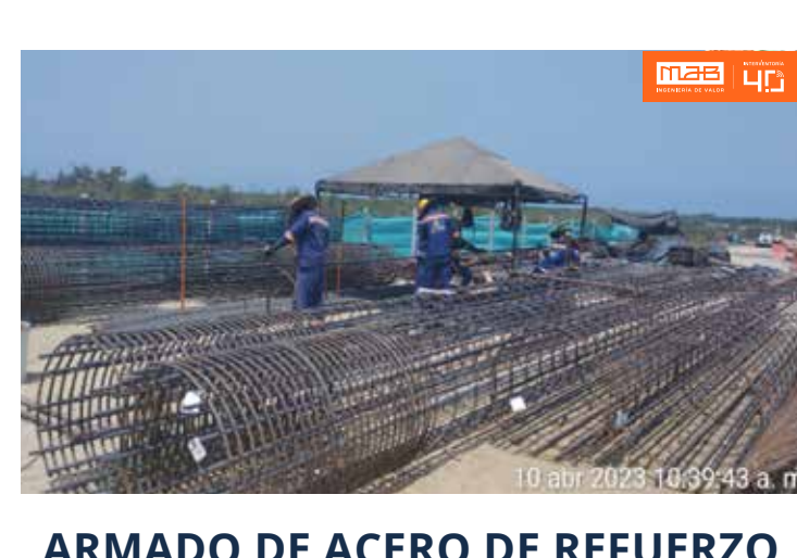
ARMADO DE ACERO DE REFUERZO
