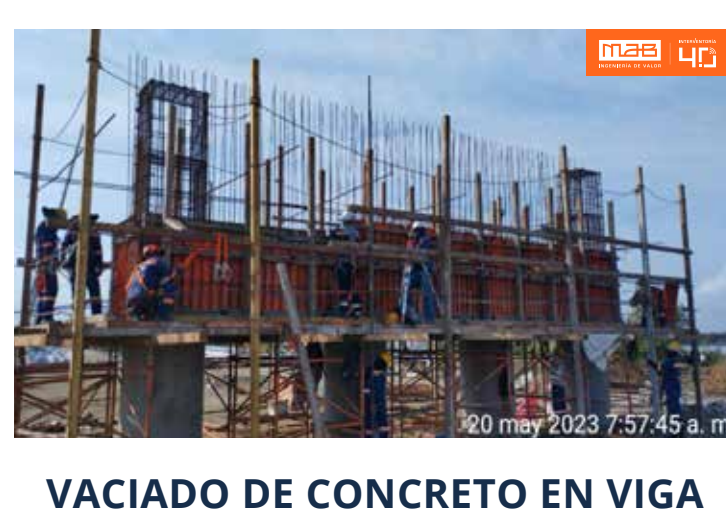
VACIADO DE CONCRETO EN VIGA CABEZAL
