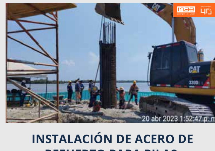
INSTALACIÓN DE ACERO DE REFUERZO PARA PILAS
