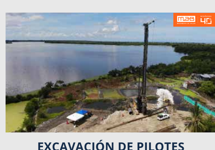
EXCAVACIÓN DE PILOTES
