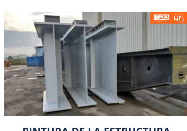
PINTURA DE LA ESTRUCTURA METÁLICA
