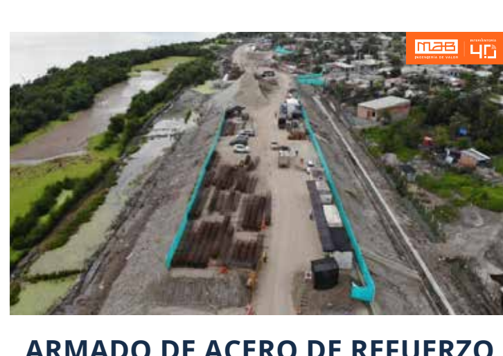
ARMADO DE ACERO DE REFUERZO
