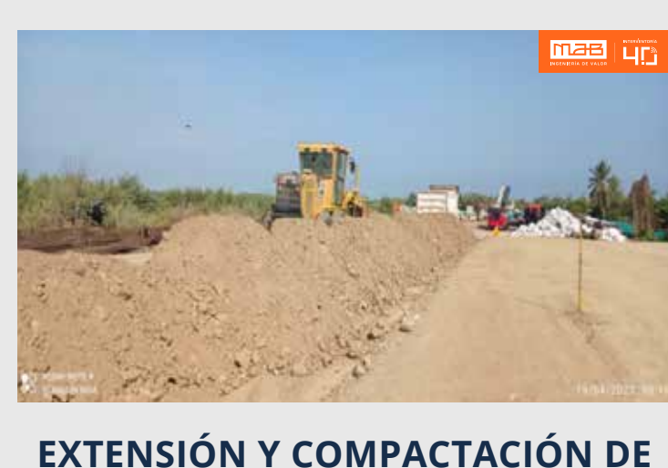
EXTENSIÓN Y COMPACTACIÓN DE MATERIAL DE TERRAPLÉN
