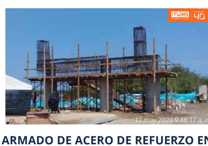
ARMADO DE ACERO DE REFUERZO EN VIGA CABEZAL
