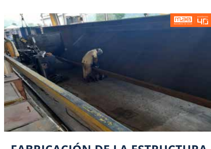
FABRICACIÓN DE LA ESTRUCTURA METÁLICA
