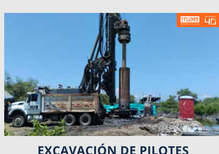
EXCAVACIÓN DE PILOTES
