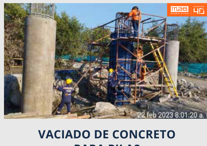
VACIADO DE CONCRETO PARA PILAS
