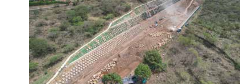
K4+050 - K4+485 (435 m): Viaducto sobre quebrada Las Lajas.
