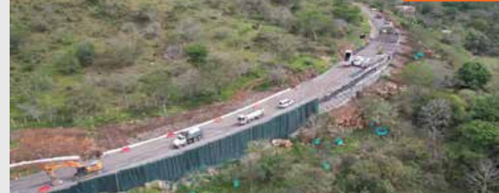
K0+690 - K1+140: Muro Tierra Armada.
