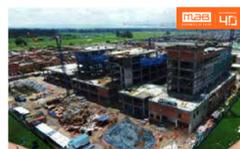
Avance en actividad de levantamiento de muros de mampostería y secos, e inicio de instalación de acabados, fachadas sate y estructura metálica.
